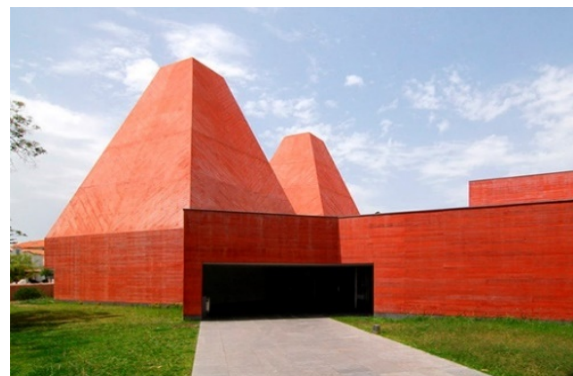
Figura 3. 16 - Edifício público em betão armado pigmentado [W34]
