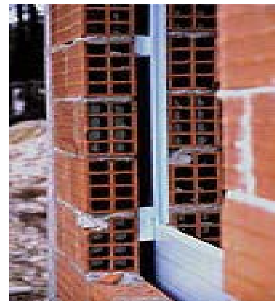
Figura 3. 21 - Solução construtiva em Parede dupla [W40]
