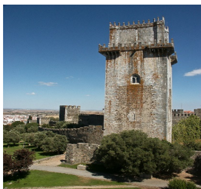
Figura 3. 3 – Fachada e protecção - Torre de Menagem, Beja, [W21]
