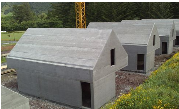
Figura 3. 15 - Habitação Social em betão armado - Açores [W33]
