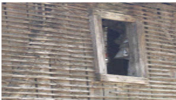
Figura 3. 9 - Parede em tabique, Praia de Mira [W27]
