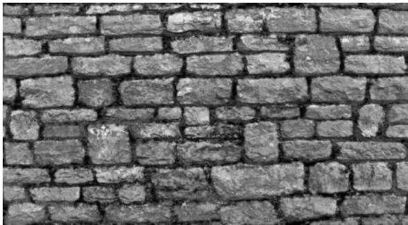
Figura 3. 7 - Alvenaria de pedra aparelhada [W25]
