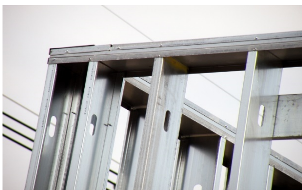
Figura 3. 25 – Estrutura metálica de suporte à parede em LGSF [W44]
