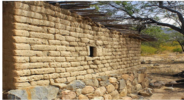
Figura 3. 6 - Parede em Adobe [W24]
